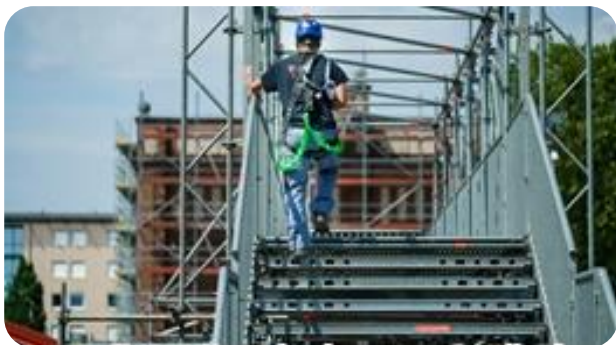
Abbildung 2: Ein Gerüstbauer bei der Arbeit auf einem Gerüst. (Quelle: Bundesinnung Gerüstbau)
