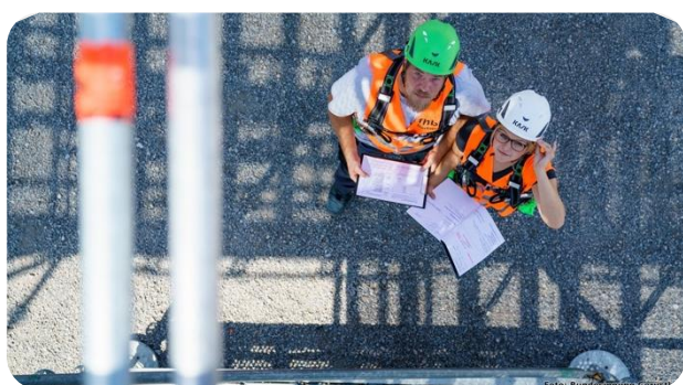
Abbildung 1: Eine Gerüstbauerin mit einem Kollegen bei der Arbeit. (Quelle: Bundesinnung Gerüstbau)
