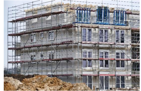
Abbildung 2: Gerüst um Neubau (Bild: Pixabay)
