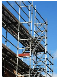
Abbildung 1: Gerüst aus Stahl (Bild: Pixabay)
