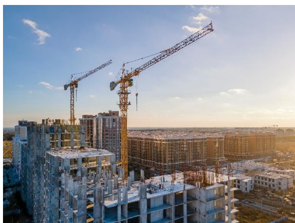
Baustelle mit Baukranen (©Adobe Stock; Mny-Jhee)
