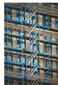
Baugerüst (© Pixabay; Didgeman)
