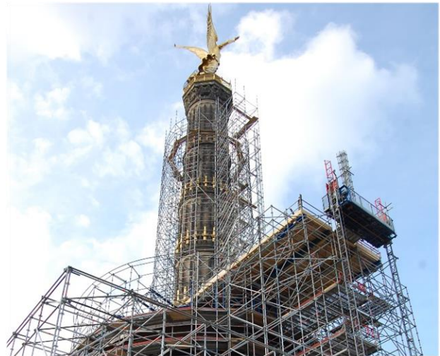
Abbildung 1: Einrüstung Siegessäule Berlin (Bild: Bundesinnung Gerüstbau)
